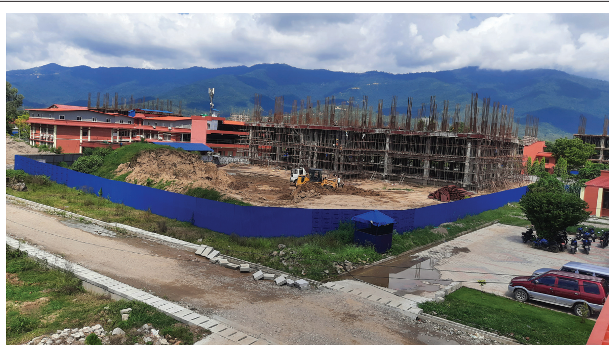
बन्दै छ प्रदेश राजधानी | लुम्बिनी प्रदेशको राजधानी राप्ती उपत्यका (देउखुरी) दाडमा निर्माण भइरहेको मुख्यमन्त्री कार्यालयको भवन। राजधानी देउखुरी सरेपछि मुख्यमन्त्री कार्यालयलगायत मन्त्रालयका भवन निर्माणको कार्य तीव्र गतिमा अघि बढेको छ।
