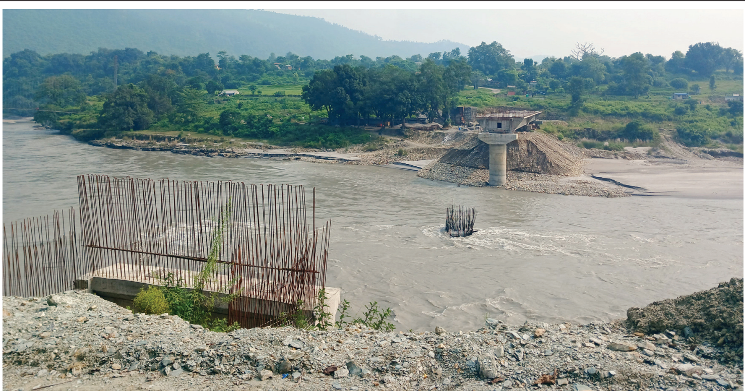
निर्माणधीन पक्की पुल पाल्पाको रामपुर नगरपालिका-१ र तनहुँको धिरिङ गाउँपालिका-१ स्थित कालीगण्डकी नदीको पुट्टारघाटमा निर्माण हुँदै गरेको पक्की पुल । तस्बिर: सुरीला रेग्मी/रासस
