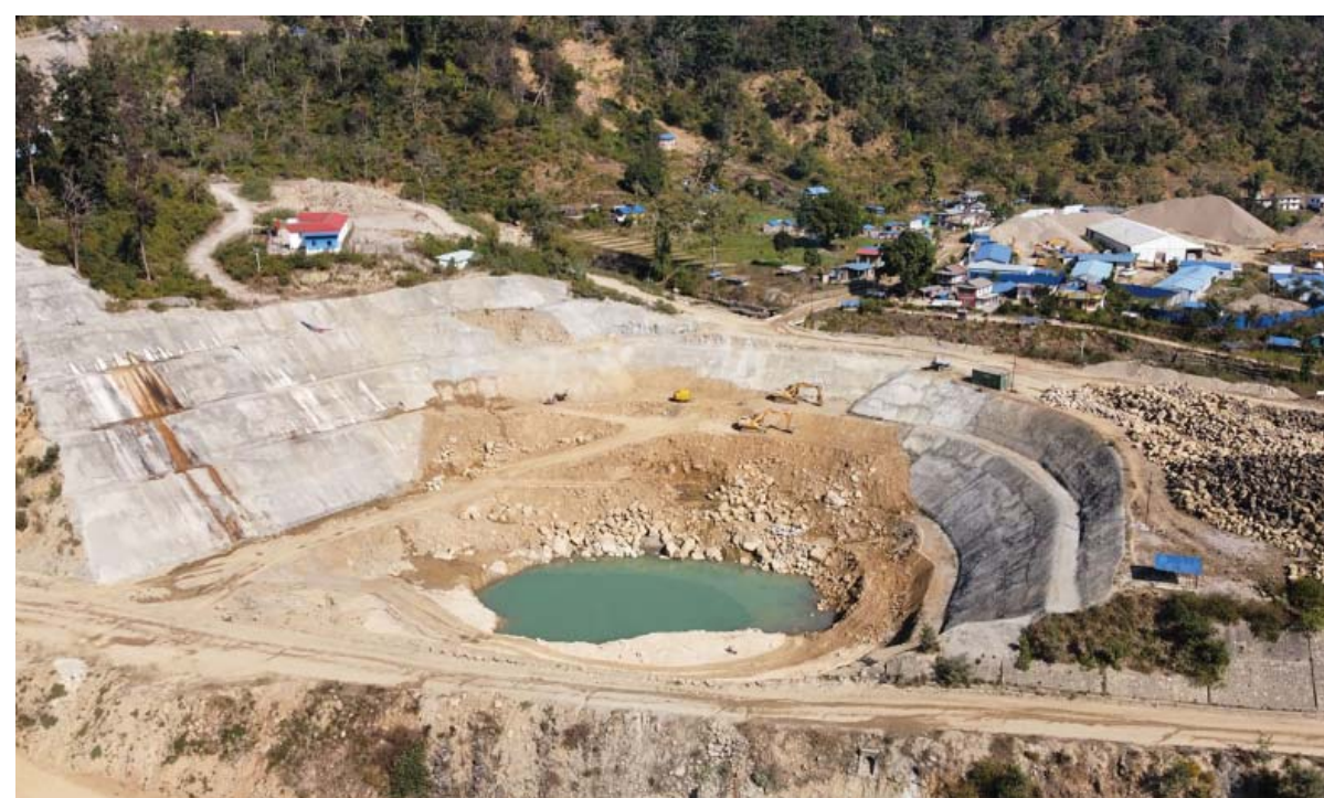
विद्युत् पावरहाउस निर्माणस्थल | सुर्खेतको भेरीगंगा नगरपालिका-९ बबईमा रहेको भेरी-बबई बहुउद्देश्यीय डाइभर्सन आयोजनाको विद्युत् पावरहाउस निर्माणस्थल।
