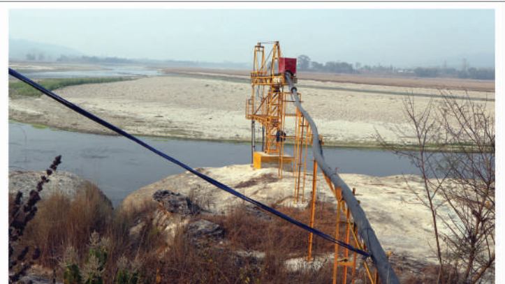
सिन्धुवाला लामि अर्ध लिफ्ट कितव भूमिगत संयोजनात्मक जन सिन्धुवा आद्योजनाले सक्कानपुरको बगमती गाउँपालिका वडा नम्बर २ राईगाउँस्थित बगमती नदीमा निर्माण गरेको जेन लिफ्ट सिन्धुवा अर्धोजना। तस्वीर: सन्ध अधिकारी, रासल
