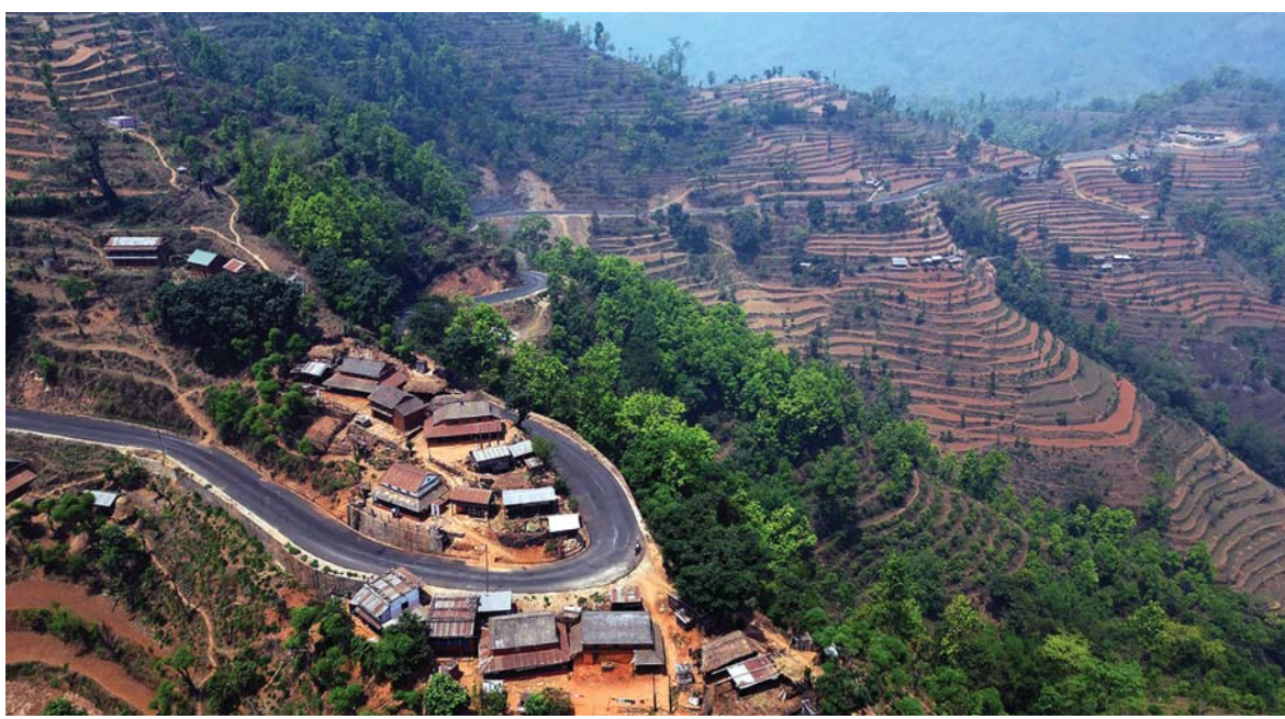
ग्रामीण तनहुँको धिरिङ गाउँपालिका-४ मा कालोपत्र भएको सडक। गण्डकी प्रदेश सरकारको गौरवको आयोजनाअन्तर्गत मानपुरदेखि डेडागाउँ जोड्ने सडकको ११ किलोमिटर दूरीमा कालोपत्र भइरहेको हो।
