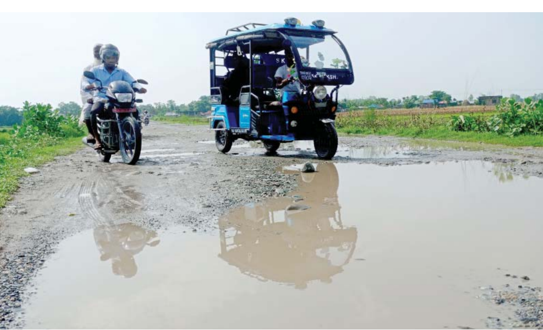
सडकको दुरावस्था इलुवा-सत्तेरभोरा-विराटनगर सडकको दुहवी-१२ स्थित बुडरीखण्डको खाल्डाखुल्डीमा जमेको पानी । समयमा सडक मर्मतसम्भार नहुँदा वर्षाका बेला पानी जमेको खाल्डाखुल्डीमा दुर्घटना हुने सम्भावना बढेको छ । तस्विर: नवीन गडौँ/रासस
