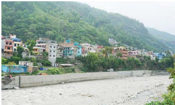
गरेको रौताह-बिएनकी कन्ट्रक्सन जेभीले बेनी नगरपालिका-८ स्थित कालीगण्डकी किनारमा १६४ मिटर लामो र आठ मिटर अग्लो काउन्टर फोर्ट र ग्राभिटी प्रविधिको पक्की पखाल निर्माण गरेको छ ।
