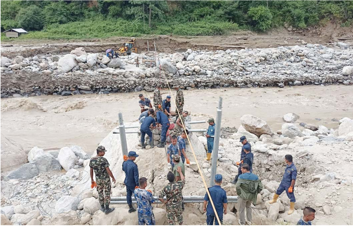
खोलामा फड्के निर्माण गर्दै सुरक्षाकर्मी यही असोज १२ गतेको बाढीले बेलिब्रिज बगाएपछि मेची राजमार्गअन्तर्गत पाँचथरको फिदिम नगरपालिका-४ र हिलिहाड गाउँपालिका-७ को सीमा हुँदा खोलामा मानिसको आवतजावतको व्यवस्थाका लागि फड्के निर्माण गर्दै सुरक्षाकर्मी। तस्विर: रवीन्द्र काफ्ले/रासस
