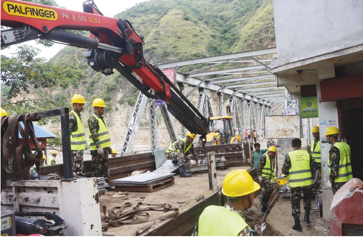
असोज १० गतेदेखि १३ गतेसम्म परेको अविरल वर्षापछि सुनकोशी नदीमा आएको बाढीले आधा भाग बगाएको सिन्धुलीको खुर्कोट र रामेछापको मन्थली जोड्ने पुलमा बेसी ब्रिज जडान गर्दै नेपाली सेनाको टोली । तस्विर सौजन्य: नेपाली सेना
